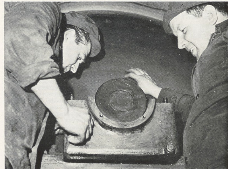
Ležaje sušilnih valjev je pregledovala skupina pod vodstvom tovariša Oražma
