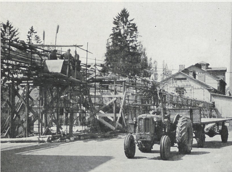
Obnova konstrukcije in instalacij-parovod, elektrovod
