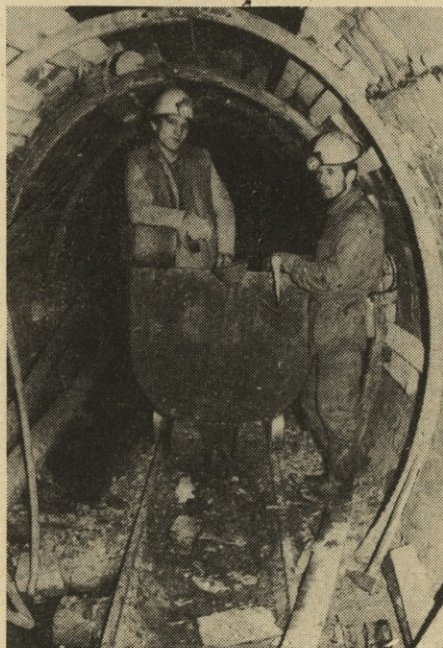
Sodelavca do RGD — tozd RIG pri obzidavi dostavne proge v hrastniški jami. (Foto J. Kirič)
