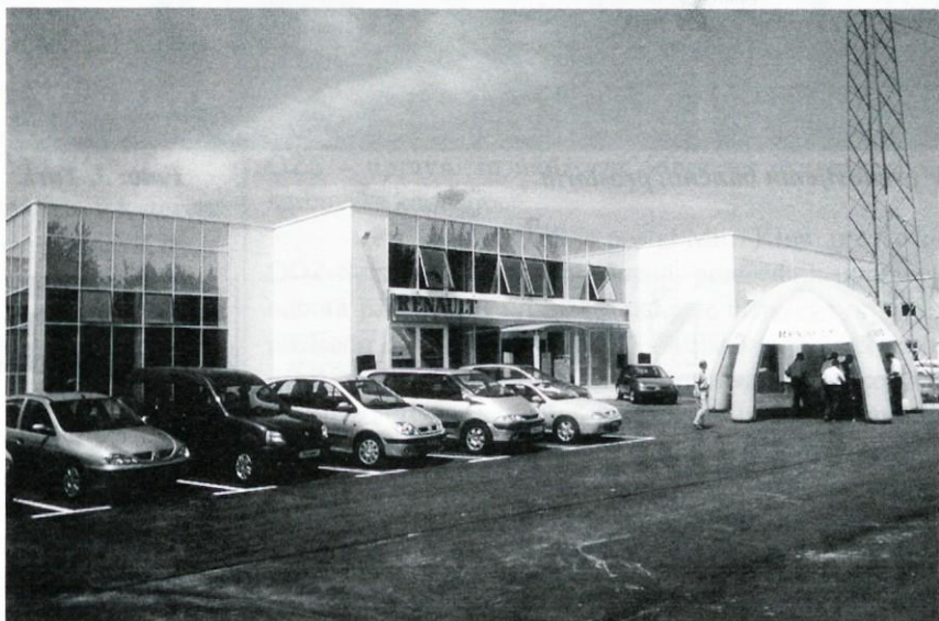
PSC Tolmin je 21. junija odprl nov servis v obrtni coni.
