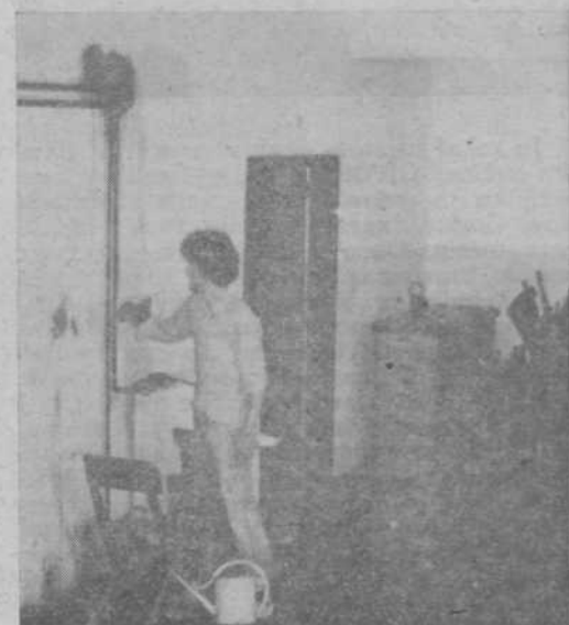
Obnovitvena dela v domu kulture Smlednik
