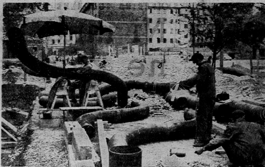
Delavci »Toplovoda« pripravljajo jeklene cevi za polaganje v Čufarjevi ulici v Ljubljani. Pri delih je predvsem zahtevno polaganje krivin, ki jih morajo zvariti neposredno na kraju polaganja. Foto: Z. Deniša
