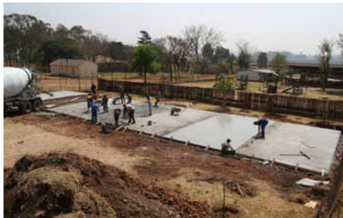
Slika 1: Knjižnica in učilnica, 2010: betoniranje talne plošče.
