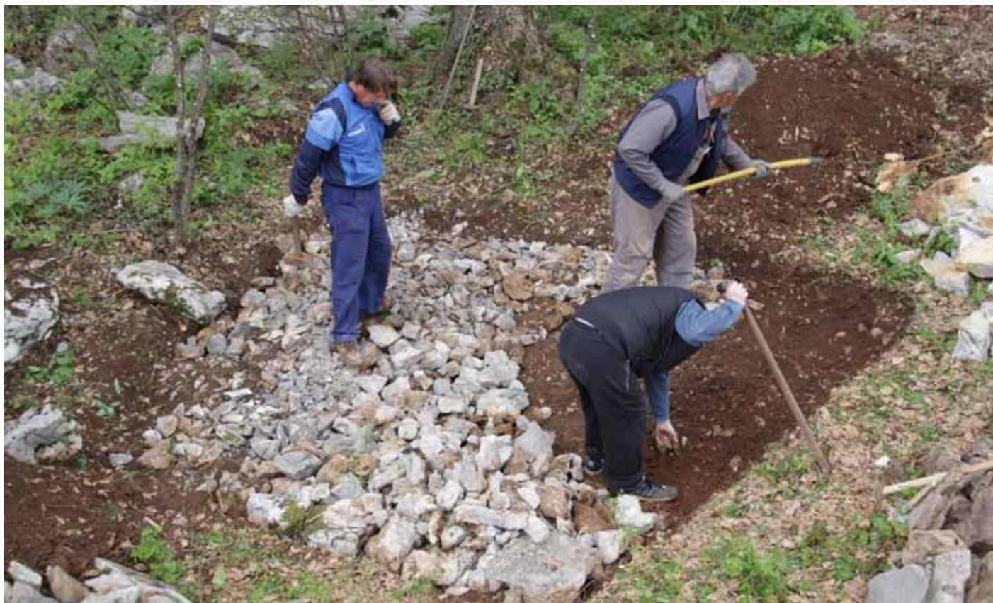
Slika 1: Priprava temelja hiške.
