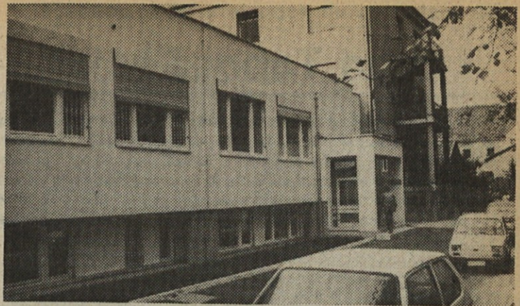
Četrta stranica otroške klinike je grajena tako, da bo omogočala kasnejšo nadzidavo.
