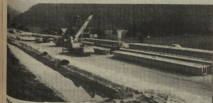
Načasno deponijo pripeljani nosilci čakajo na montažo.
