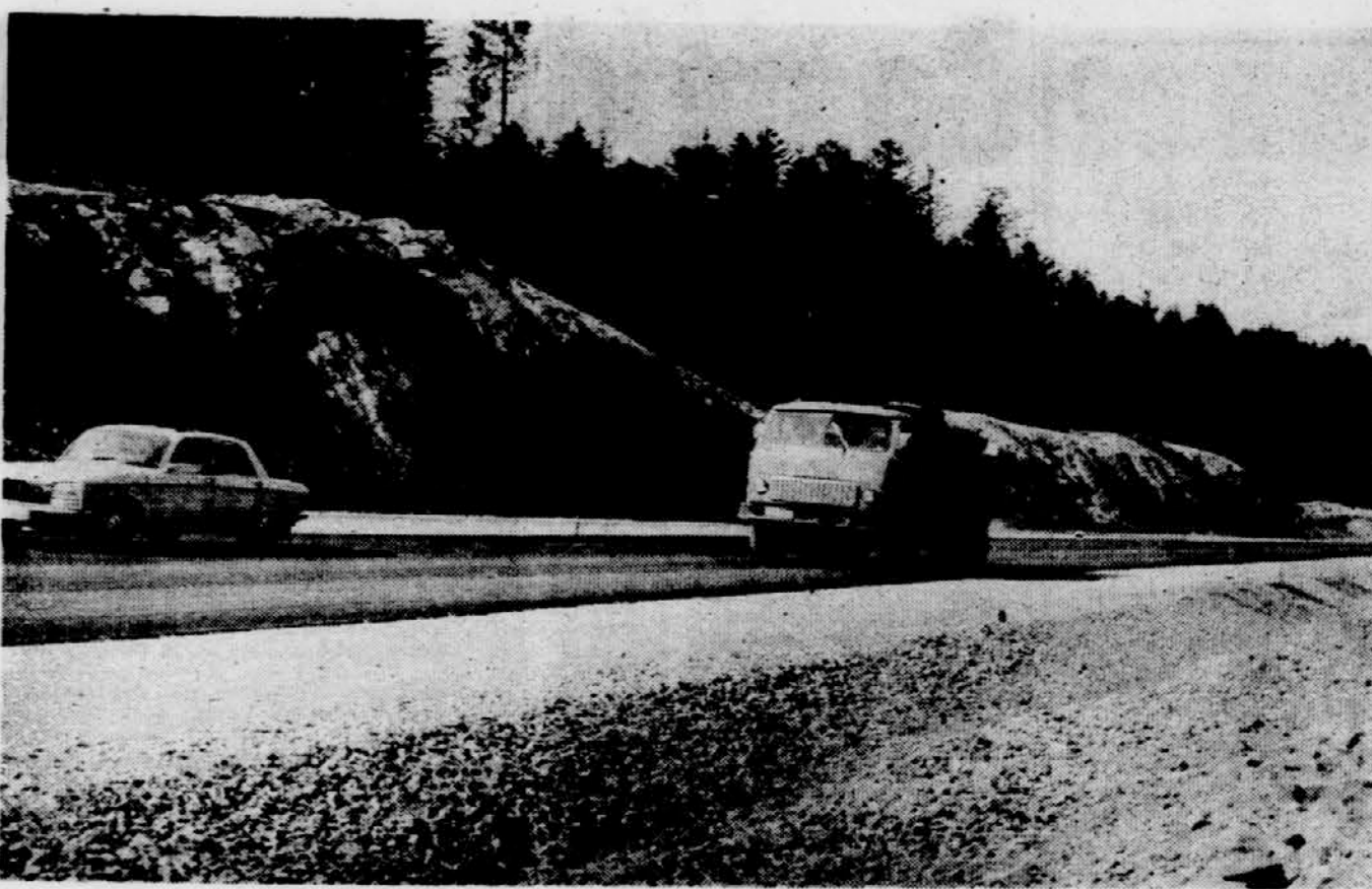
GRADITELJI ZE PO ASFALTU — Podjetje »Partizanski put« iz Beograda, ki gradi odsek avtomobilske ceste Vrhnika—Logatec, je že asfaltiralo del novega cestišča in imajo na tem cestnem odseku kaj opravka z gradnjo.
