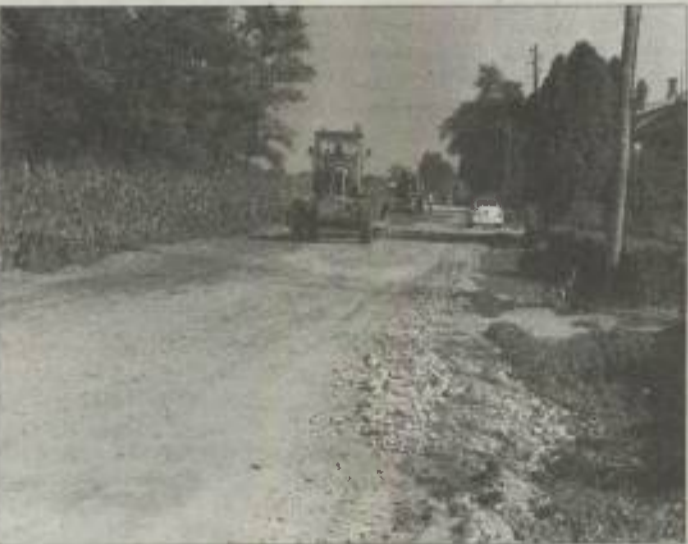
CESTA DO GANČANOV V NOVI PREEBLEKI - Na asfaltiranem odseku ceste med Lipovci in Gančani, ki je bil že močno načet, je te dni zelo živahno. Popravila te pomembne prometne povezave so se lotili delavci SGP Pomgrad - Nizkogradnje. Fotografija: M. JERŠE
