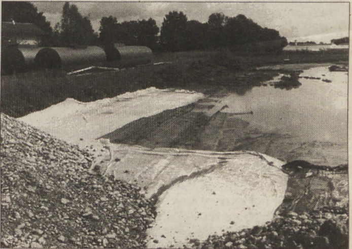
Pomgradovi delavci so septembra začeli pripravljala gradbena dela za nov Petrolov bencinski servis na Meleh.
