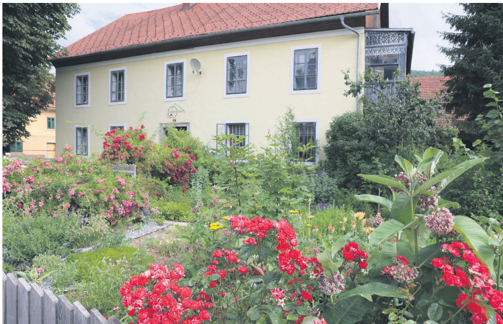
Pred stavbo Zavoda Stanislava je energijski medeni vrt.
