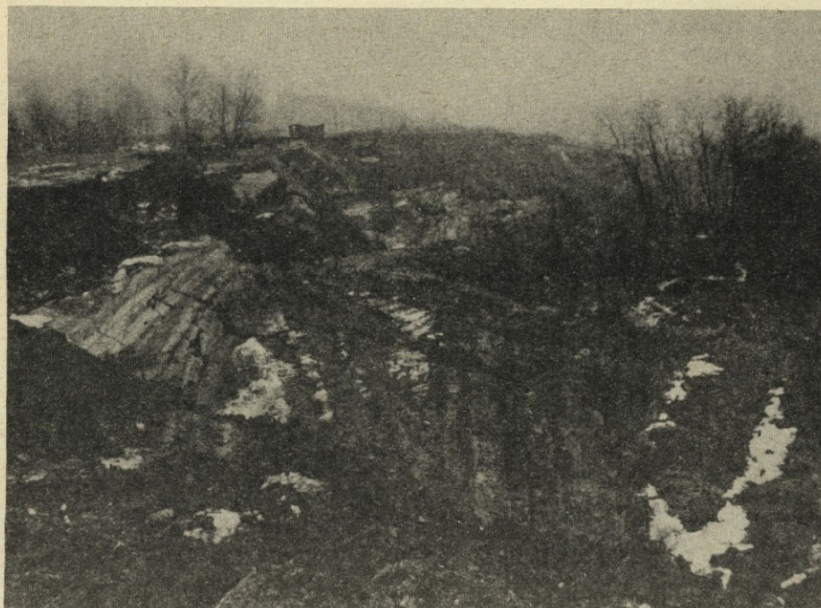
Dne 18.2.1987 se je sprožil zemeljski plaz iz Ruardija v Zagorju
