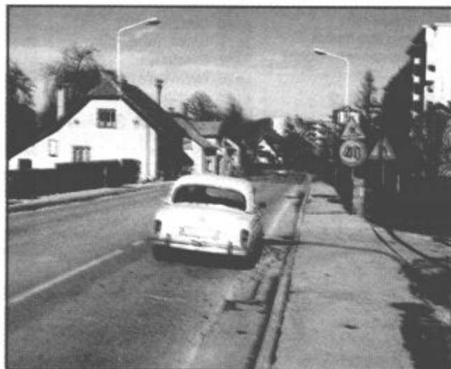
Na veselje številnih voznikov so v petek odstranili cestne zapore na Cesti talcev in v križišču proti naselju Gorica. Dela še niso končana, saj nizke temperature ne dovoljujejo zaključnih del.
