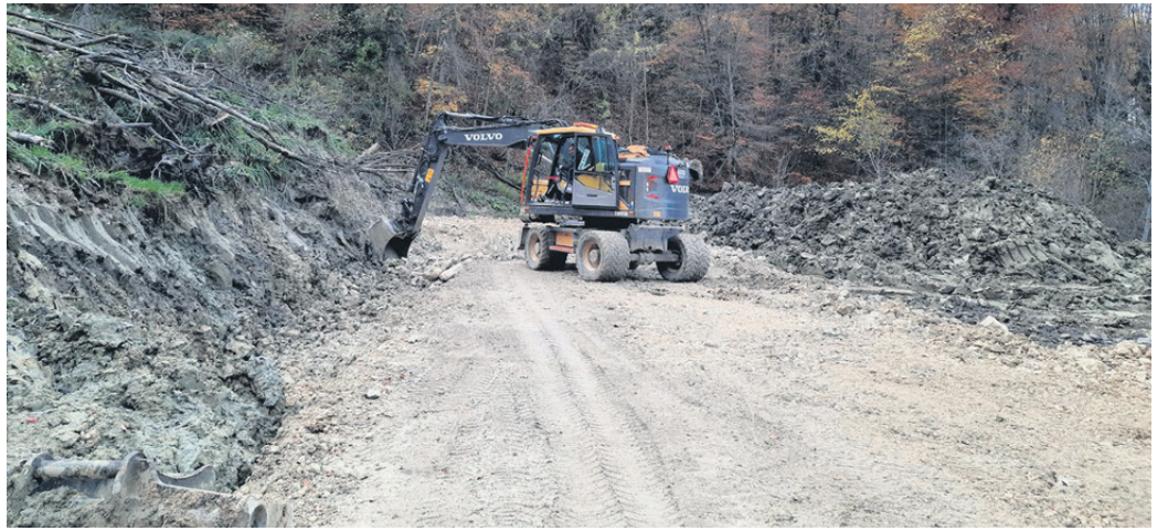
Zahtevna sanacija plazu Stopce, ki se je začela oktobra lani, bo kmalu končana. Dela so ocenjena na skoraj 1,7 milijona evrov.
