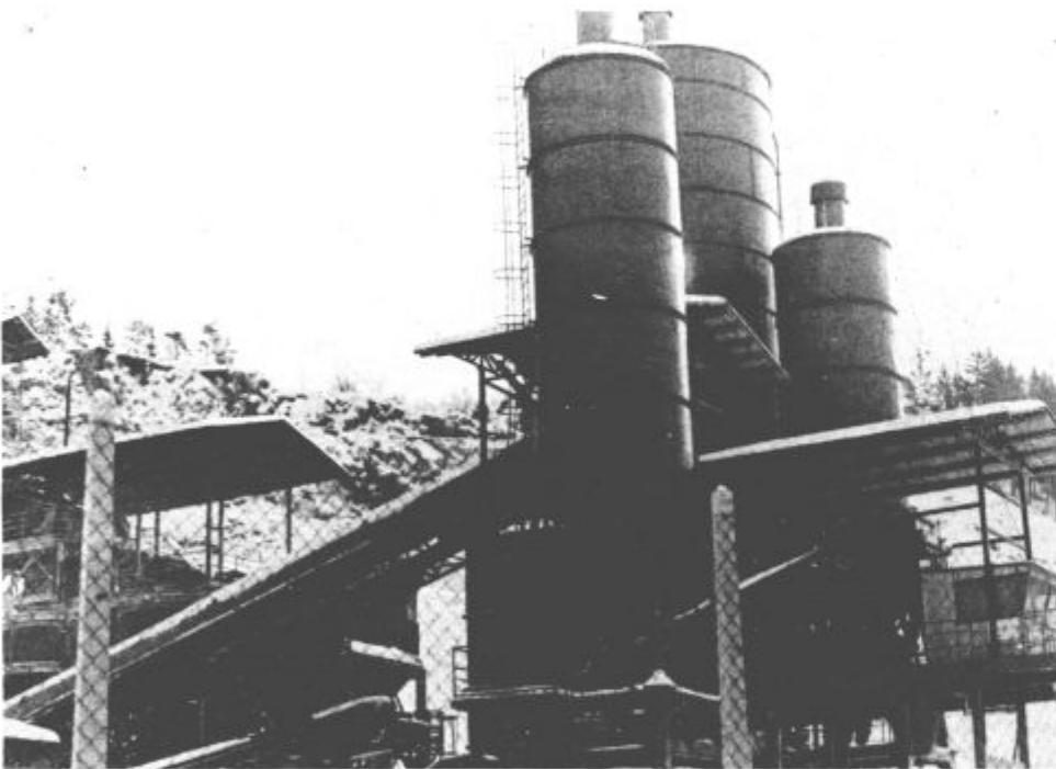
Gradisova betonarna v Podgorju pri Šmartnem ob Paki.
