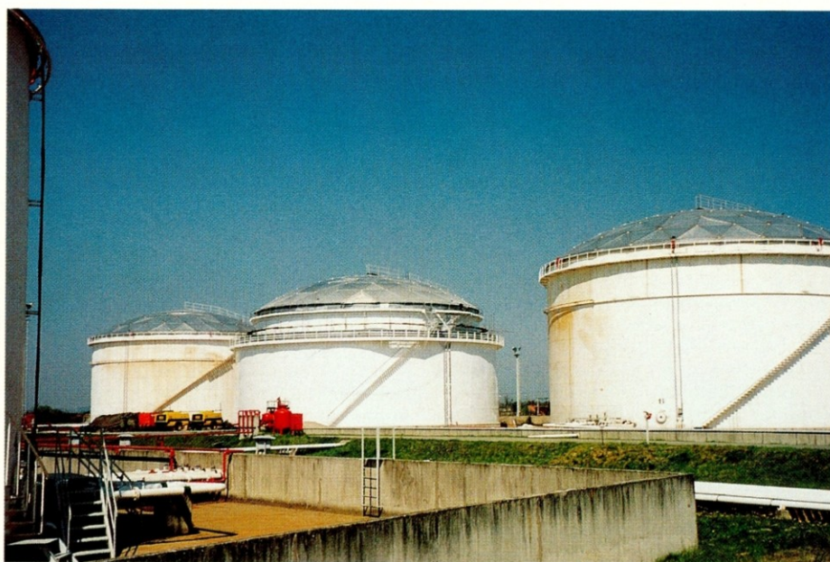
Že na prvi pogled vidite razliko med starim in novim rezervoarjem
