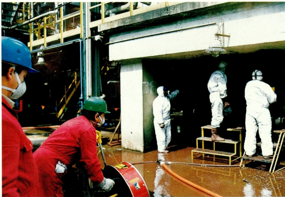
Od 21. aprila opravljajo redni letni remont tovarne metanola. V tem času tehnična reševalna enota družbe v prisotnosti poklicne gasilske enote Nafta Lendava zamenjuje tudi sintezni katalizator. Vodja zahtevnega remonta je Jože Muršič, delo pa opravljajo delavci Nafta Lendava skupaj s specializiranimi zunanji podizvajalci. V glavni fazi je bilo v remont vključenih 50 ljudi.
