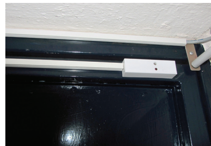
Pritrditev senzorja tresljajev (H) na vhodna vrata
