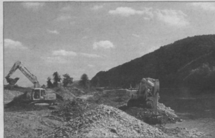
Ureditev brežin Save akumulacijskega bazena HE Blanca
