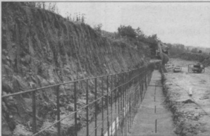
Gradnja armirano betonskega opornega zidu (foto: D. Markošek)
