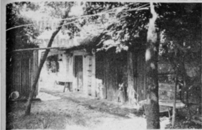
Le nekaj let bo še potrebno pa bosta lesena hiša in slamnata streha samo še preteklost tudi na območju KS Makole
