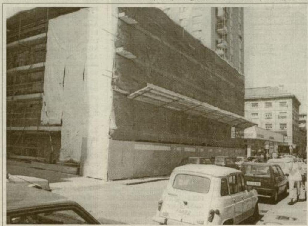
Pod strokovnim nadzorom Zavoda za varstvo naravne in kulturne dediščine Celje, ki je pripravil tehnični posnetek fasadne členitve, so delavci GP Remont Celje konec maja začeli z obnovitvenimi deli, trajala pa bodo predvidoma 2 do 3 mesece. Na novo bodo izvedeni fasadni ometi, v Remontu pa so že začeli z izdelavo odlikov dotrajane fasadne členitve ter okrasja.
