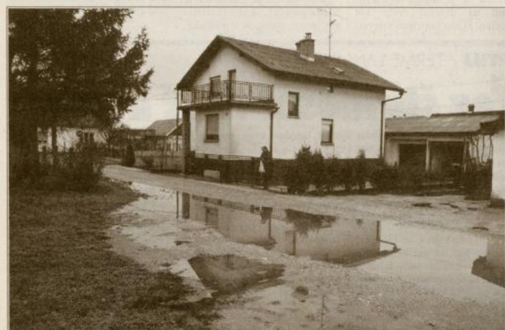
Zaradi parkiranja tovornjaka poškodovana cesta.
