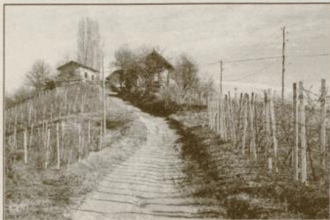
Še letos bodo asfaltirali strmi klanec v Mejah.
