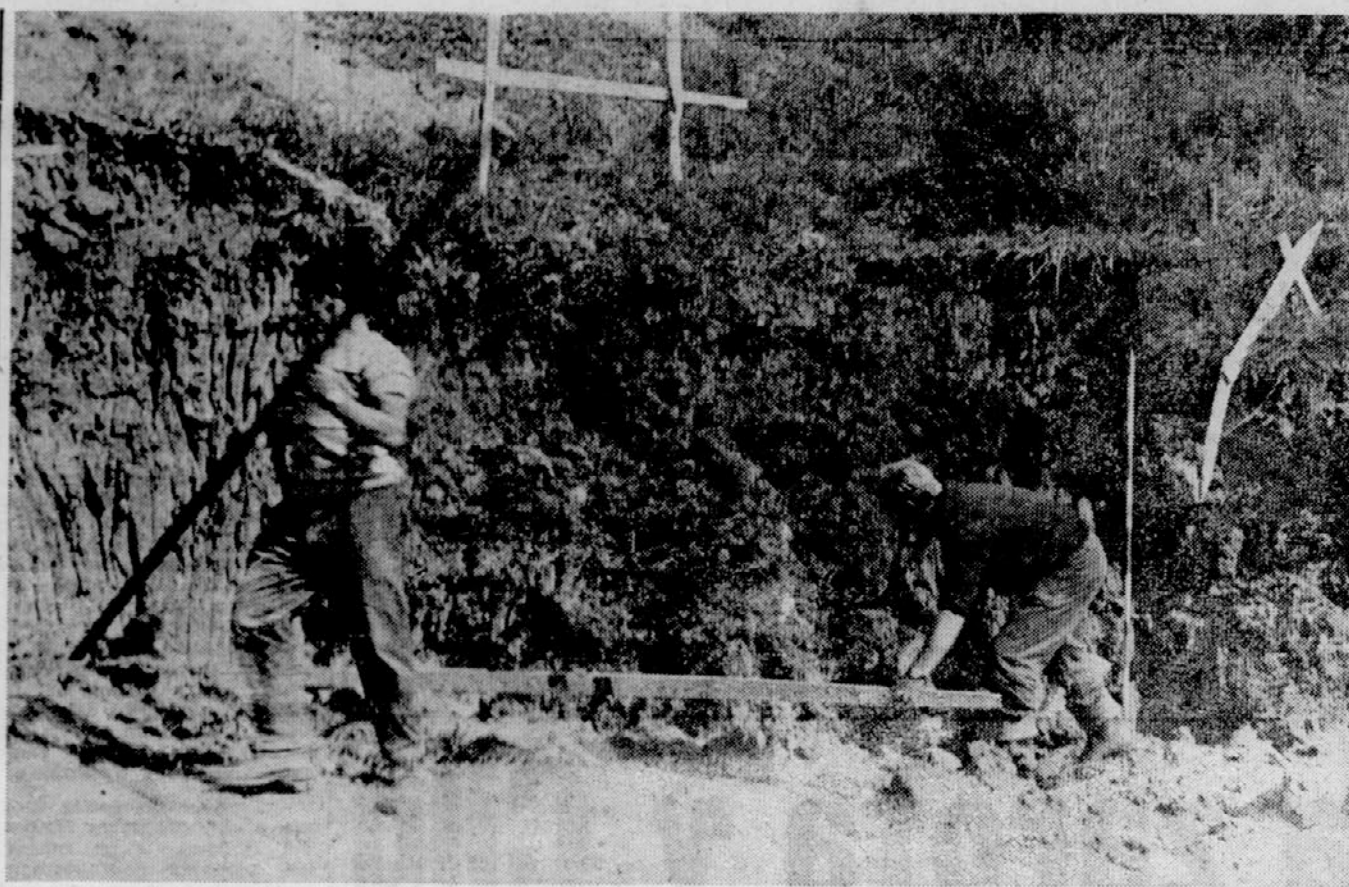
BOJ Z ZEMELJSKIMI PLAZOVI — Podjetje za urejanje hudournikov iz Ljubljane se je prejšnji teden spoprijelo s trenutno najbolj nevarnim plazom v Hrastniku, s tistim pri trafostaciji. Zaradi stalnega drsenja so morali prenehati z odvozom zemlje in že začeti z utrjevanjem oziroma betoniranjem tal (na sliki). Na ogroženem področju bodo postavili tudi betonske kaše.
