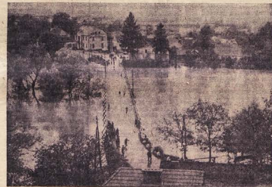
MED POPLAVO SE JE GLADINA KRKE DVIGNILA ZA TOLIKO, DA JE PRI KRSKI VASI SEGALA VSE DO MOSTU. KLJUB NEVARNOSTI JE MOST VZDRŽAL PREIZKUSNJO, PREBIVALCI PA SO VESELI, DA GA NI ODNESLO
