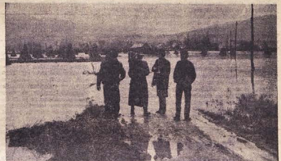
VSE POTI DO MOSTECA SO POPLAVLJENE. VODA DERE CEZNJE, V VAS PA SE DA PRITI SAMO S ČOLNOM
