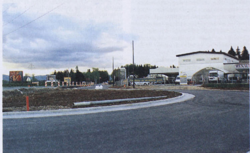
Predvideni rok za dokončanje je septembra 2003
