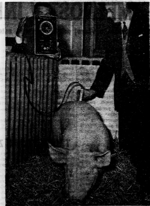
»Do ščetine natančno« je mogoče izmeriti deželno maso na živem prašcu z novo angleško napravo, ki deluje na ultrazvočne valove.
