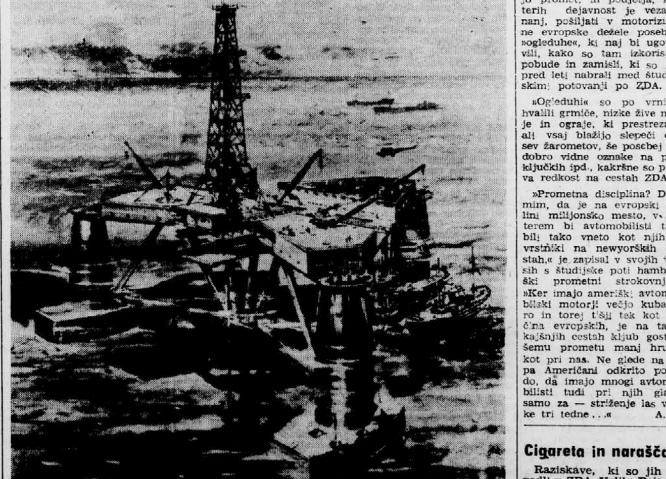
UMETNI OTOK ZA NAFTO — Po nizozemskem uspehu se je razvnela pravcata dirka za nafto in zemeljski plin pod dnom Severnega morja. Silka kaže model, po katerem bodo Angleži zgradili umetni otok z vrtnalnim stolpom. Ploščad bo opirna na tri jeklene noge, zasidrane v morskem dnu, ali pa jo bodo nosili posebni splavi. Ogradje v obliki trikotnika s stranico kakih sto metrov bo na treh opornih (premer 3,5 m), ki bodo stali na 33 m dolgi, 20 m široki in 22 m visoki pontonih. Svedri za poskusne vrtnice bodo prodrli do globine 4.000 m, »plavaljoča« tovarna bo imela razen stanovanjskih prostorov s klimatičnimi napravami in ploščadi za helikopterje tudi vse potrebno za pridobivanje pitne vode ter štiri Dieslove motorje (vsak po 1500 konjskih moči).
