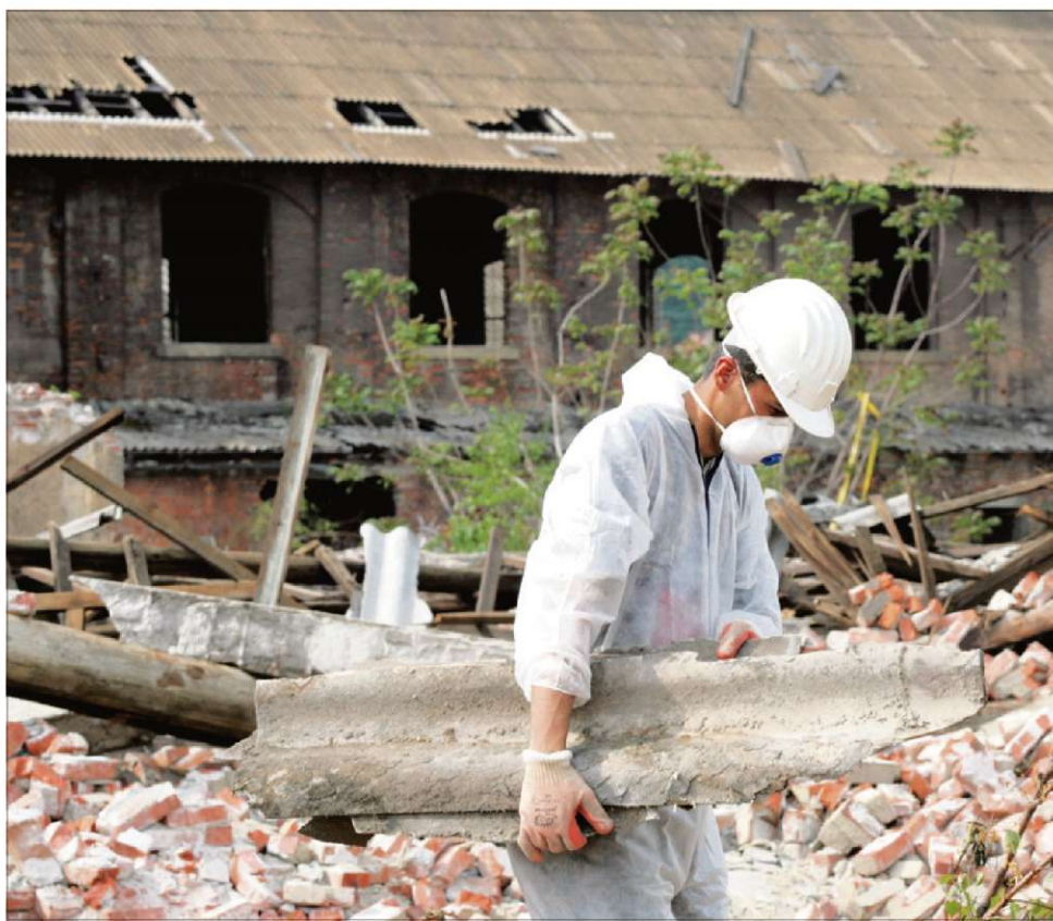
Pri odstranjevanju azbestnih plošč je potrebna posebna previdnost. (Foto: SHERPA, arhiv NT)
