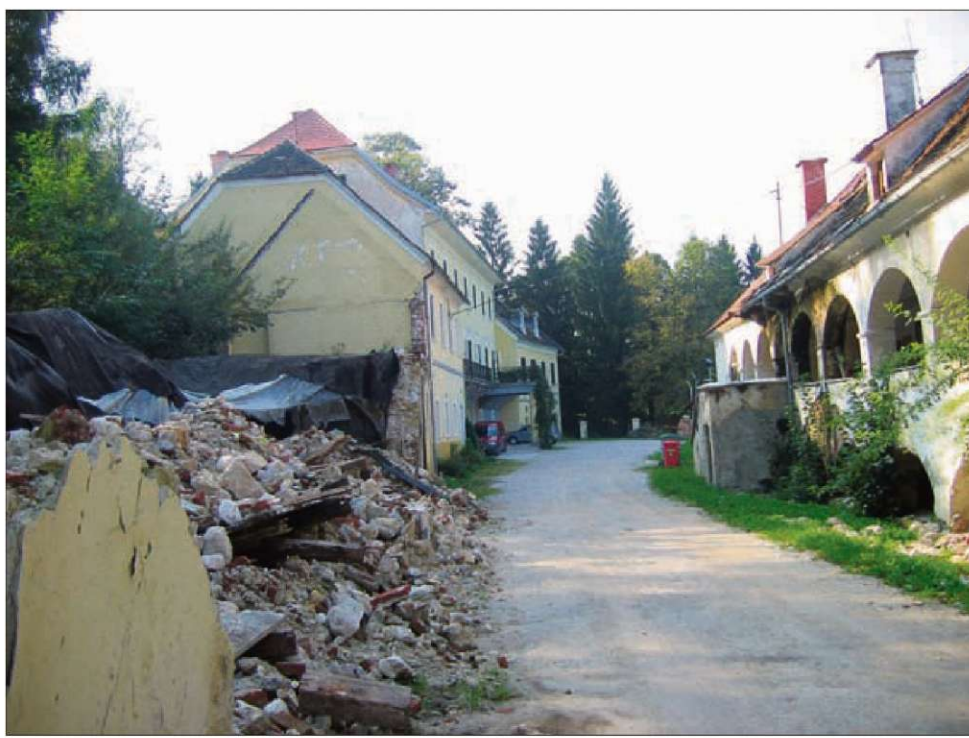
Tako je izgledalo območje dvorca Trebnik pred tremi leti, danes je v bistveno slabšem stanju. Objekt B (na desni strani fotografije) bodo končno obnavljali.
