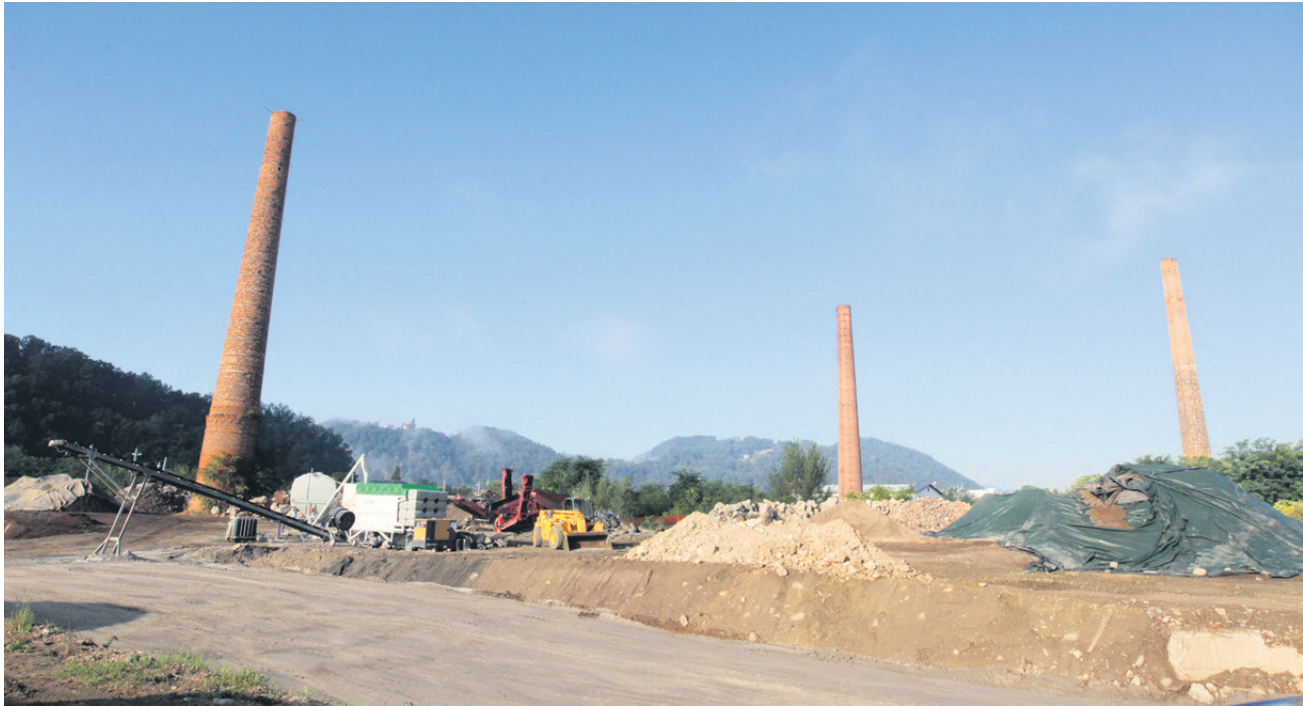
Izvajalec sanacijskih del na območju Stare cinkarne, za katero je odgovorna celjska občina, še dela. Predviden rok za končanje predelave onesnažene zemljine je 31. julij. Je pa občina od izvajalca že prejela predlog za podaljšanje roka, ki ga v tem trenutku še preučuje in ga bo najverjetneje podaljšala do konca avgusta. Skupno bo šentjursko podjetje na območju Gaberje jug predelalo 13.600 kubičnih metrov z nevarnimi odpadki onesnažene zemlje.
