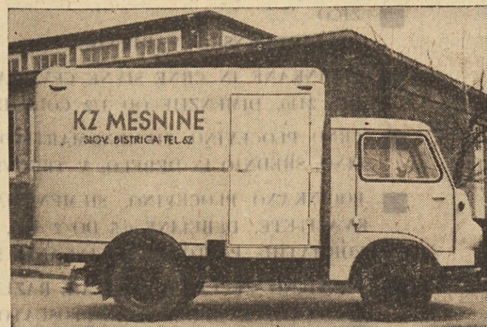
Kamion-hladilnik »TAM 2000 H« za prevoz lahko kvarljivega blaga
