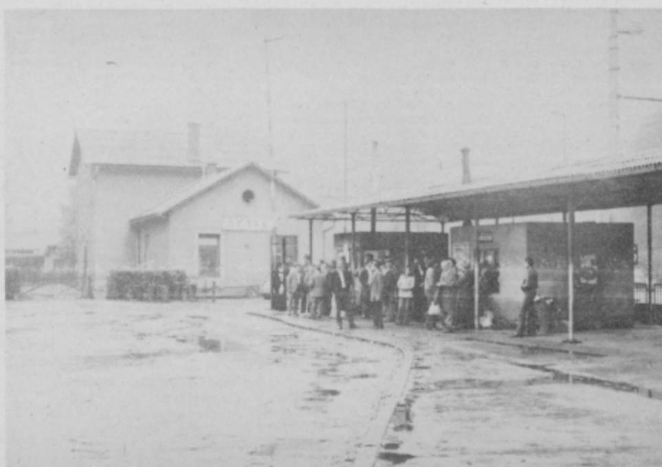
Center Štor je takorekoč tam, kjer sta avtobusna in železniška postaja. Problem je prometna ureditev, kar bo treba slej kot prej izboljšati.
