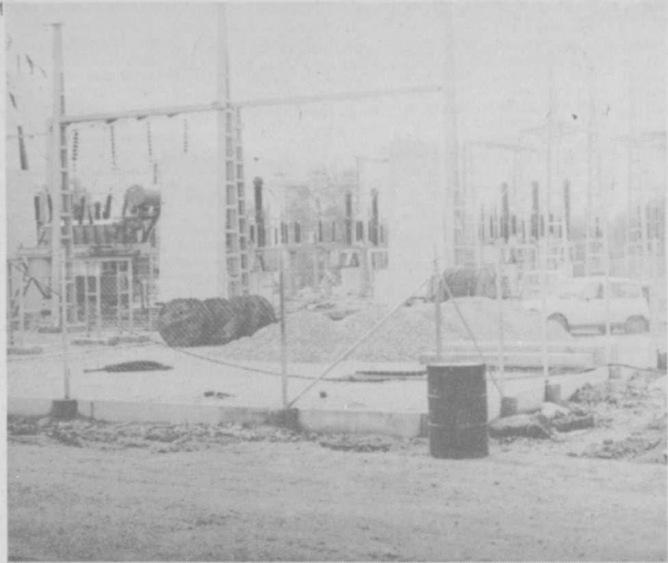
Ob šoli je v zaključni fazi gradnja industrijske postaje, ki bo namenjena za napajanje nove elektrojeklarne. Kasneje bo napajanje obeh peči potekalo preko Podloga.
