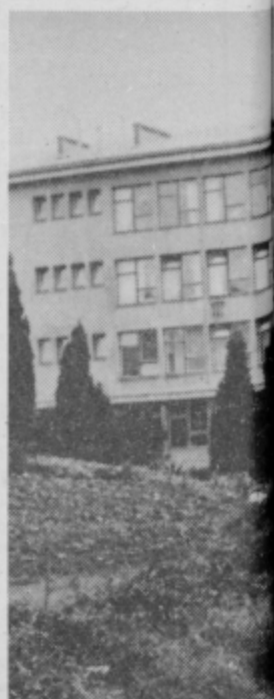
Ob sedanji osnovni šoli šolo, gradijo nov prizidek izboljšali.
