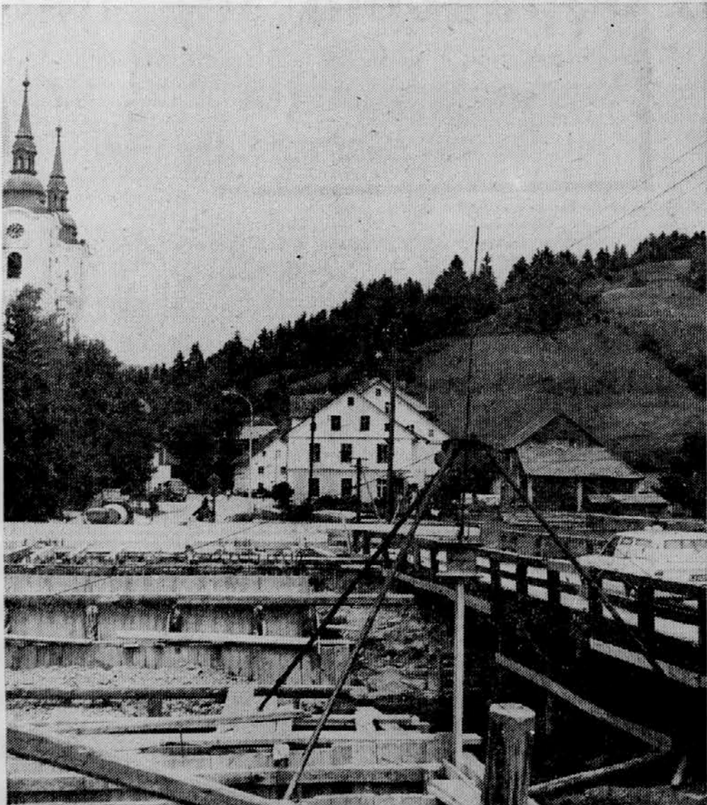
NOVI MOST — Ziri, ki po novem spet pripadajo Gorenjski, se modernizirajo. Tako bo čez nekaj tednov odslužil tudi stari leseni most čez Soro Zamenjala ga bo nova železobetonska mostna konstrukcija. S tem bodo za precej časa rešili problem transporta. Na sliki: gradbišče novega mostu.
