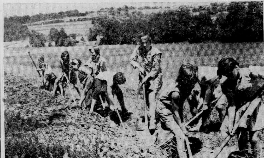
VODOVOD SO GRADILI — Na območju krajevnih skupnosti Voličina so pred kratkim zgradili vodovod v naselju Strma gora, kjer se je na vodovodno omrežje priključilo vseh 34 lastnikov hiš. Prav tako so položili glavni vod za vodovod v Spodnji Voličini, na katerega se bosta zaenkrat priključila šola in učiteljski blok. Prebivalci Strme gore in voličinski soljarji so pri graditvi vodovoda opravili precej prostovoljnega dela. Na sliki: soljarji pri kopanju jarka za glavni vod.
