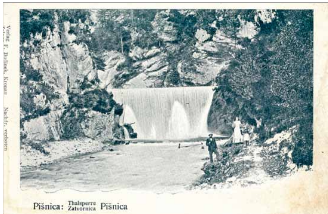
Slika 1: Hudourniška pregrada na hudourniku Pišnica nad Kranjsko Goro – v soteski Babe (založnik F. Budinek iz Kranjske Gore, razglednica izpred leta 1914, avtorjev arhiv).
