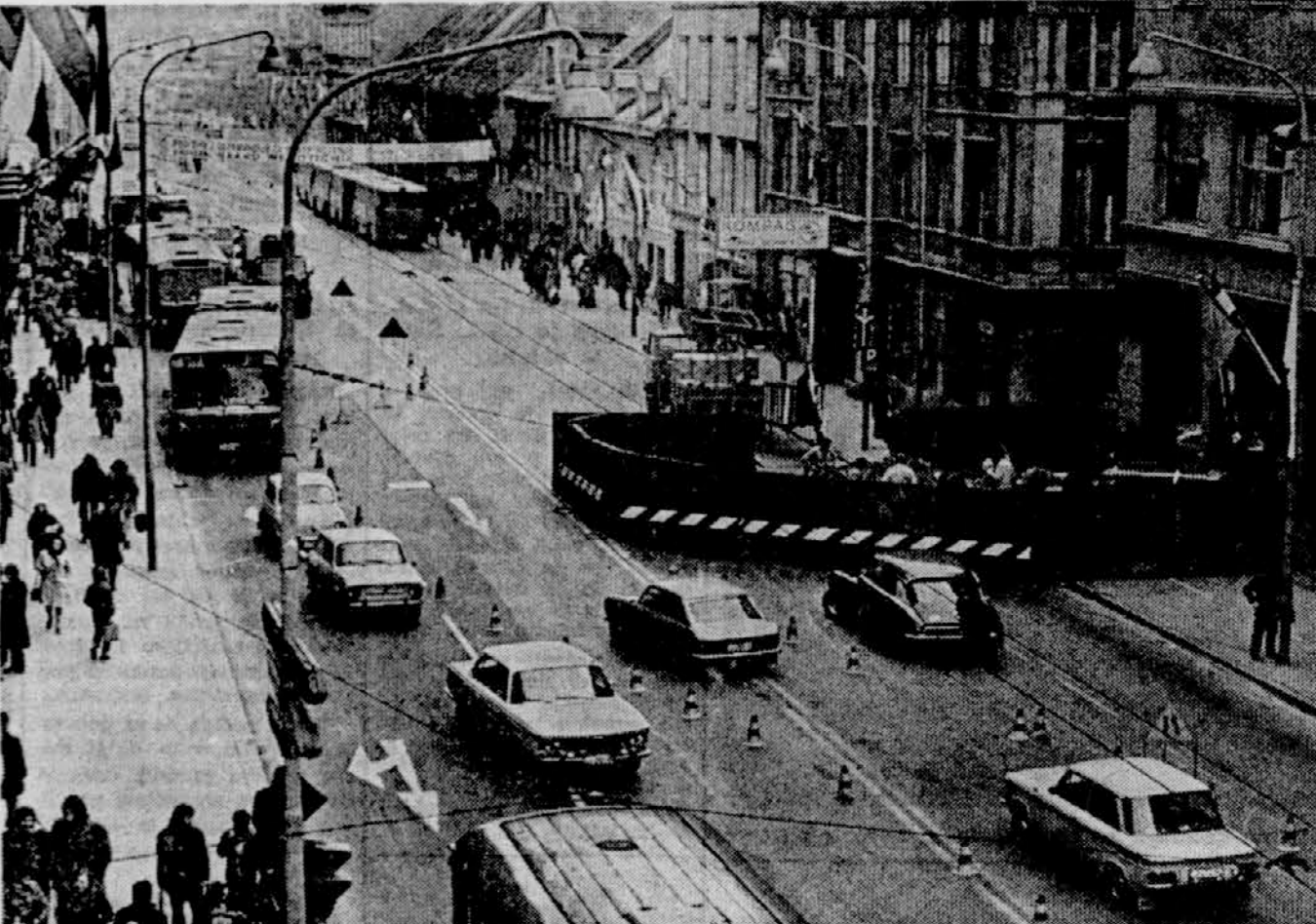
TOPOLOVOD POD TITOVO CESTO — Delavci SGP Pionir so včeraj začeli z deli pri polaganju novega toplo-voda za Mestno gledališče ljubljansko in za hotel Lev. Toplovod bo prečkal Titovo cesto pri hotelu Sion. Dela bodo predvidoma trajala 14 dni; za promet bo najprej zaprta ena in potem še druga stran cestišča.
