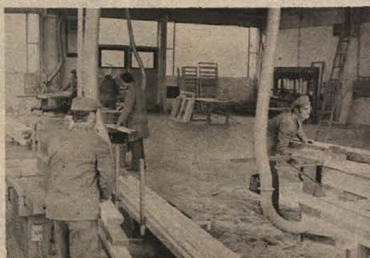
Velika in opremljena mizarska delavnica
