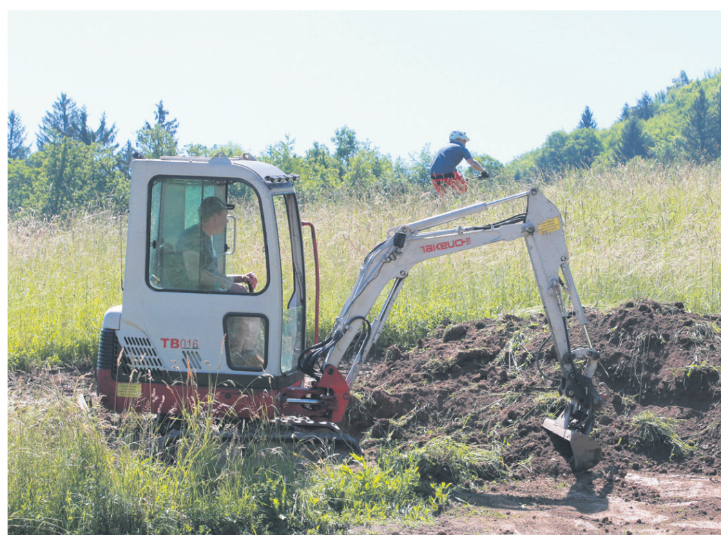
Začetna in najzahtevnejša gradbena dela so člani ŠD Vertikala opravili s pomočjo izkušenega voznika bagerja. Nato so »peli« krampi in lopate.
