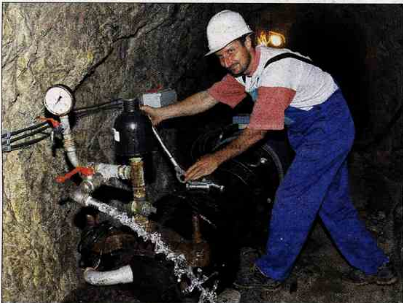
Delavci VO-KA so v cevovod vstavili nove cevi, v katere bodo v naslednjih dneh namestili tudi ultravioleto napravo, ki bo temeljito razkuževala vodo.
