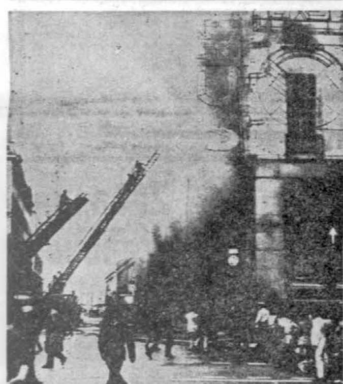
UNICEVALNI POŽAR — V štirinadstropni zgradbi sredi Torina je izbruhnil požar, v katerem sta izgubili življenje dve osebi, škode pa je bilo za več kot 100 milijonov lir.
