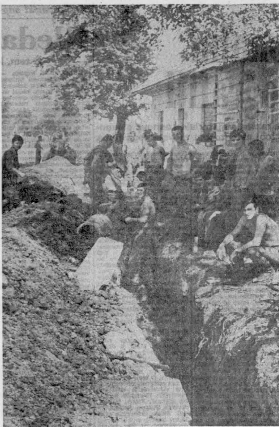
V TREH DNEH ZAMENJALI CEVI — Nedavno so vojski garnizije JLA iz Ribnice izvedli udarniško akcijo. Stare vodovodne cevi od Gorice vasi do Ribnice, ob cesti Ljubljana—Kočevje, so odslužile in so jih morali nadomestiti z novimi, večjimi. Vojski so vse delo opravili sami, občina je prispevala samo material. Pri zadnji fantje so delo opravili v pilih treh dneh. Na sliki: pripadniki ribniške garnizije med kopanjem jarka za vodovod.
