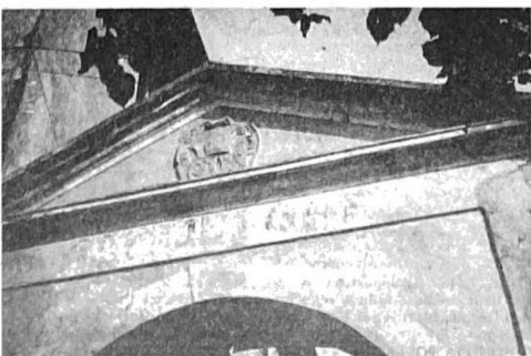
Med obnovo Vrbovca so odkrili lep grb in stari napis nad vzhodnim
