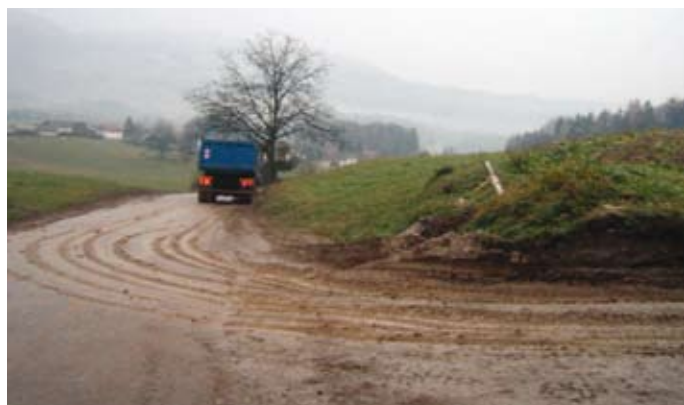
Onesnaženo cestišče zaradi neočiščenih pnevmatik ob izvozu z gradbišča na cesto.
