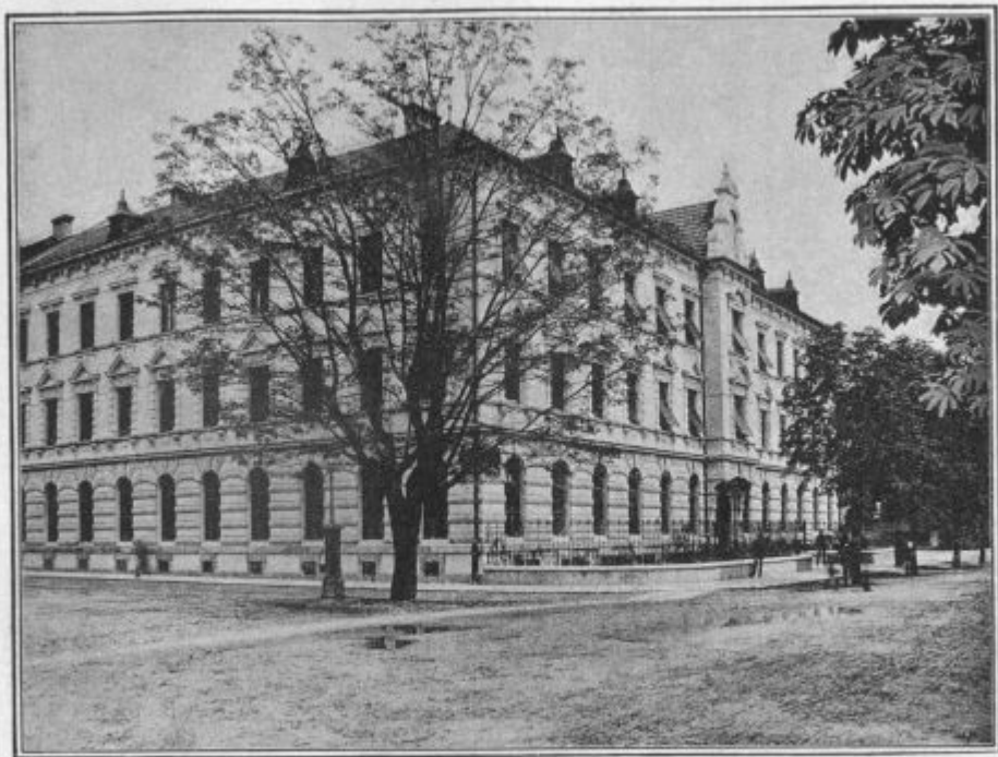
Dom Mohorjeve družbe v Celovcu.
