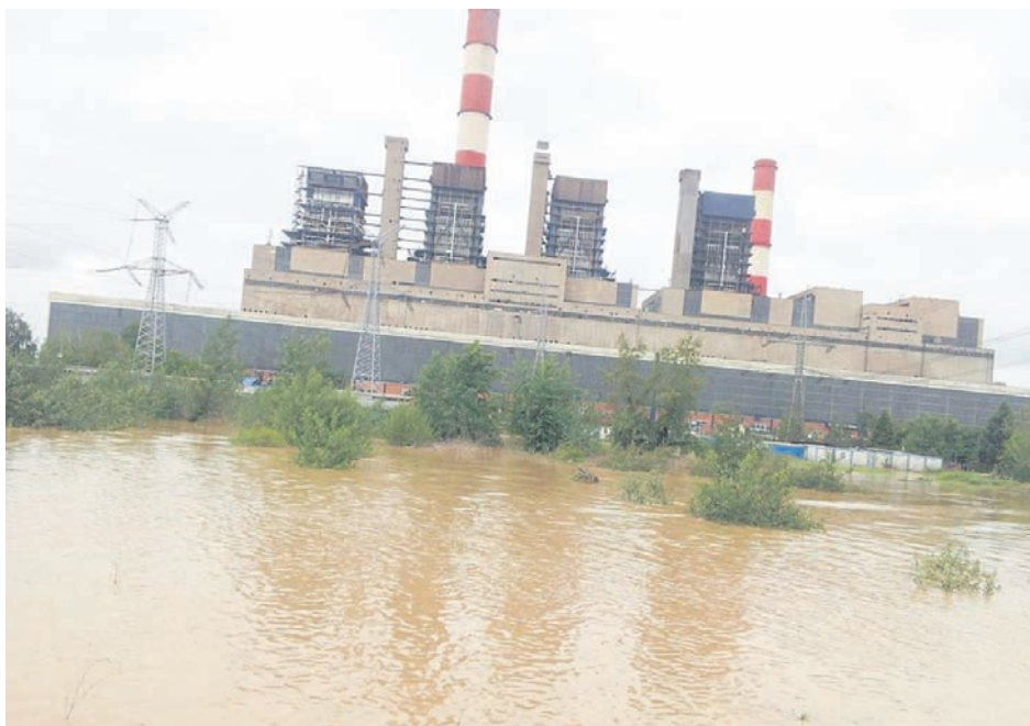
Prizor iz Obrenovca. V tamkajšnji Termoelektrarni Nikola Tesla je enota civilne zaščite črpala vodo v enem najpomembnejših elektroenergetskih objektov v Srbiji.
