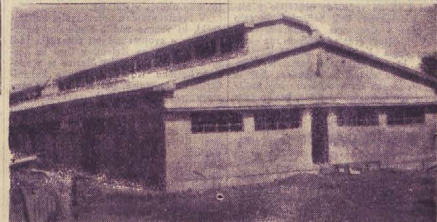
Del nove tovarne montažnih hiš v Zavidovičih
