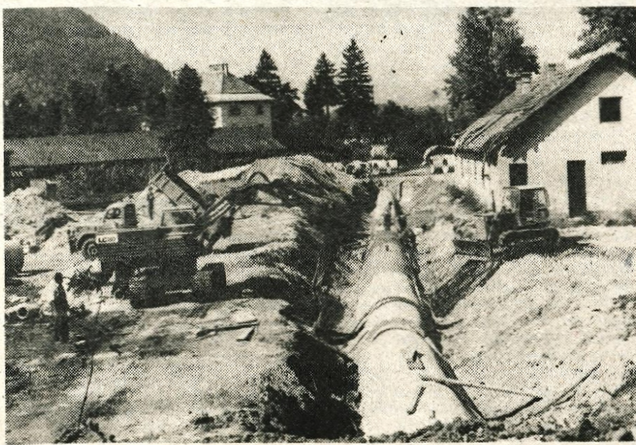
Gradnja glavnega zbiralnika GZ-4 pri Iskri
