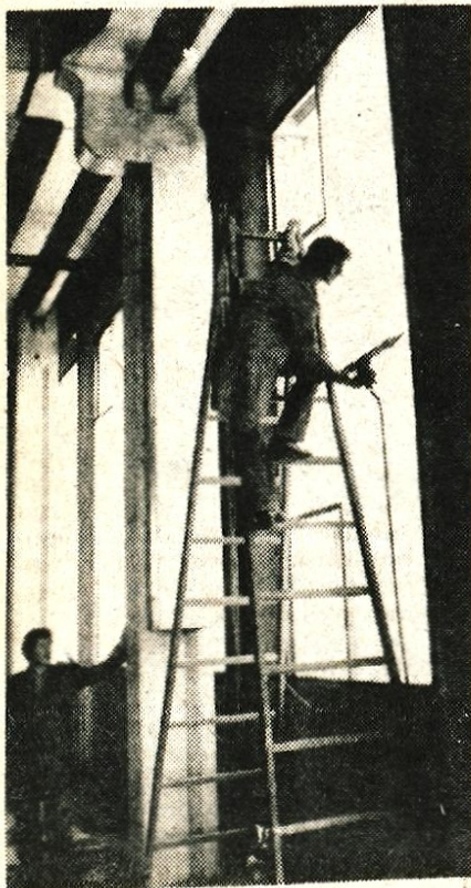
Montaža oken in copilit stekel
