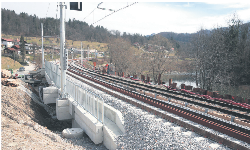
Država želi z nadaljnjim razvojem kompleksnega železniškega sistema zmanjšati zaostanek železniškega za cestnim prometom. Na fotografiji dela ob prenovi železniške proge v Rimskih Toplicah.
