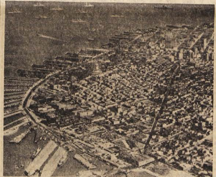
Pogled na del San Francisca
