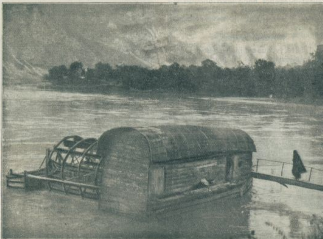
Vodni ambulančni (premestljivi) mlin v Zvorniku na Drini ob srbski meji.
