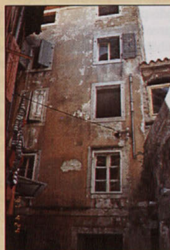
Stanovanjski objekt - Smrekarjeva 55, pred in po obnovi.
