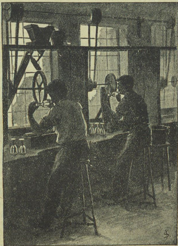
Slika 46. Brušenje steklenih izdelkov.
