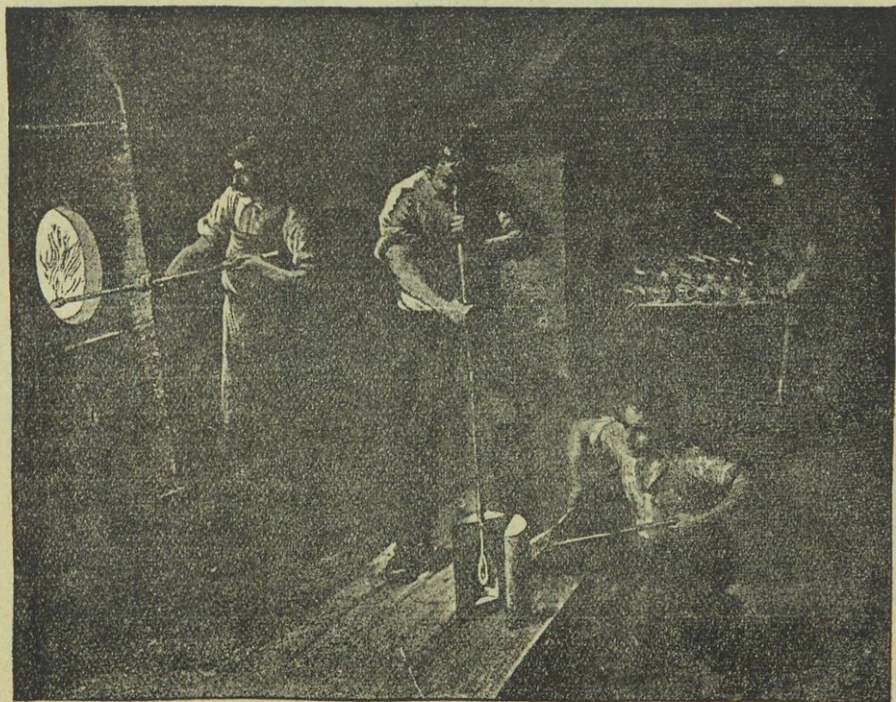
Slika 43. Pihanje stekla v steklarni; na levi steklarska peč, v sredini delavec, ki piha steklo v dvodelno otlo obliko, na desni hladilna peč.
