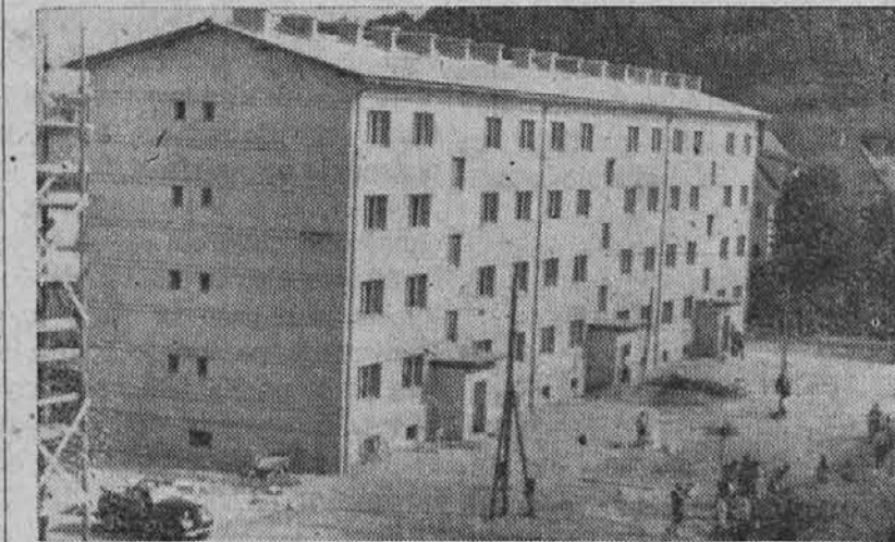
(PRVI BLOK S 24 SODOBNO UREJENIMI STANOVANJI)
