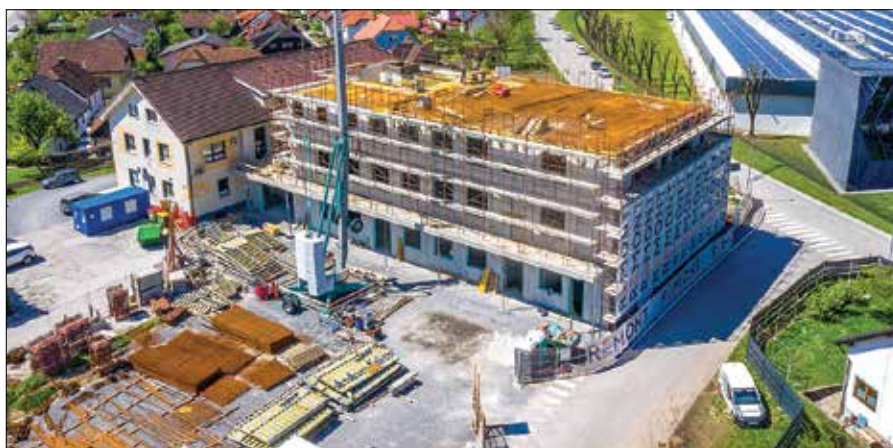
Glavni razlog za proračunski primanjkljaj je izgradnja prizidka k zdravstveni postaji v Nazarjah. (Foto: UK)
