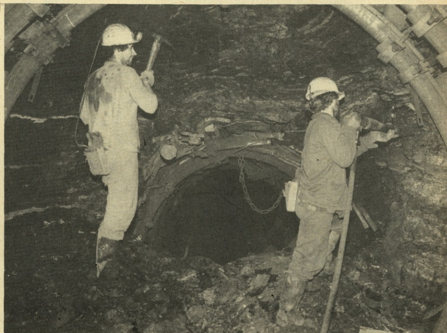
Pretesarba proge v jami rudnika Trbovlje AB polje na višini 262 m. (Foto: B. Klančar)
